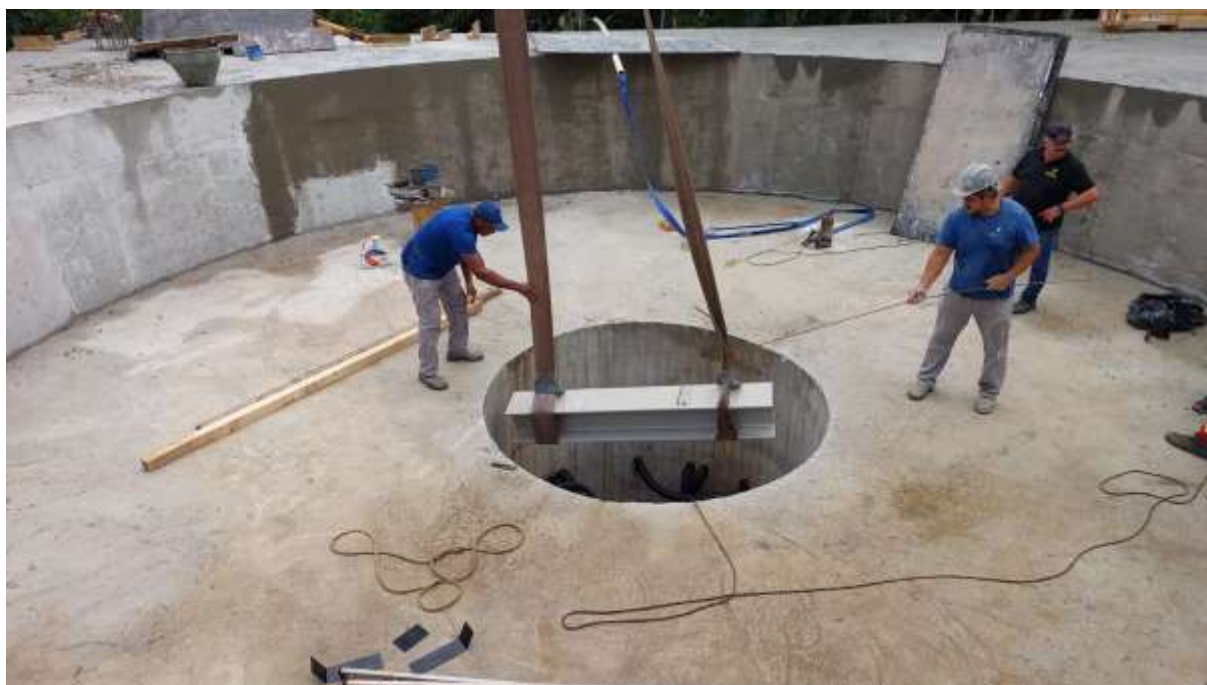
Figura 11 - Construção da base de sustentação da torre
