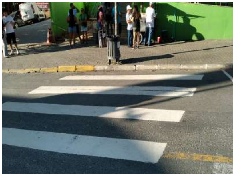
Figura 144 - Calçada sem rampa de acessibilidade, existente na Avenida Rodesindo Pavan, na testada do acesso da estação laranjeiras.
