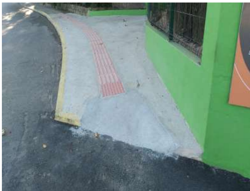
Figura 140 - Calçada com rampa de acessibilidade, existente na Avenida Rodesindo Pavan, defronte ao acesso do estacionamento da estação laranjeiras.
