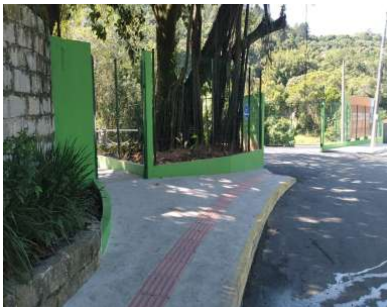
Figura 138 - Calçada com piso podotátil, existente na Avenida Rodesindo Pavan, defronte ao acesso do estacionamento da estação laranjeiras.
