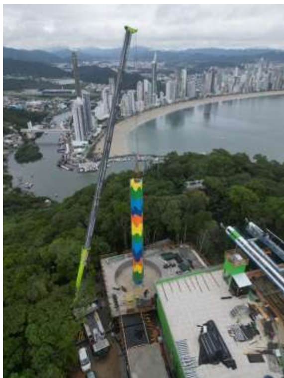
Figura 14 - Montagem dos módulos da torre
