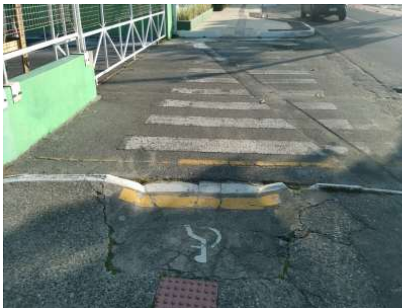
Figura 137 - Faixa de pedestres com sinalização desgastada e rampa de acessibilidade em condições inadequadas, existente na Avenida Atlântica, aos fundos do estacionamento da estação barra sul.
