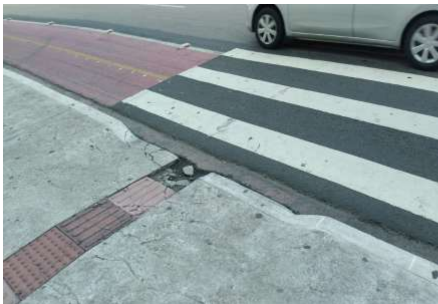
Figura 129 - Calçada com rampa de acessibilidade em condições inadequadas, existente na Avenida Normando Tedesco, do lado da estação barra sul.
