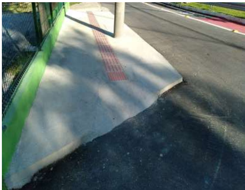
Figura 139 - Calçada com rampa de acessibilidade, existente na Avenida Rodesindo Pavan, defronte ao acesso do estacionamento da estação laranjeiras.
