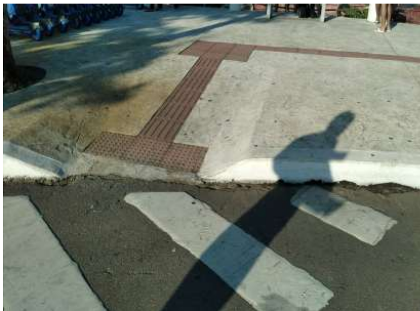
Figura 132 - Calçada com rampa de acessibilidade, existente na interseção da Avenida Normando Tedesco x Avenida Atlântica.
