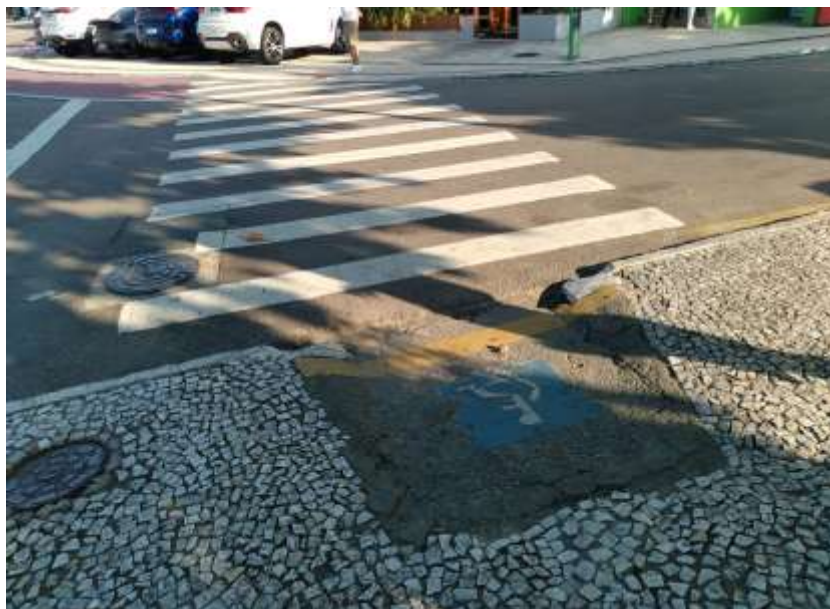
Figura 134 - Calçada com rampa de acessibilidade em condições inadequadas, existente no início da Avenida Atlântica, do lado oposto da estação barra sul.
