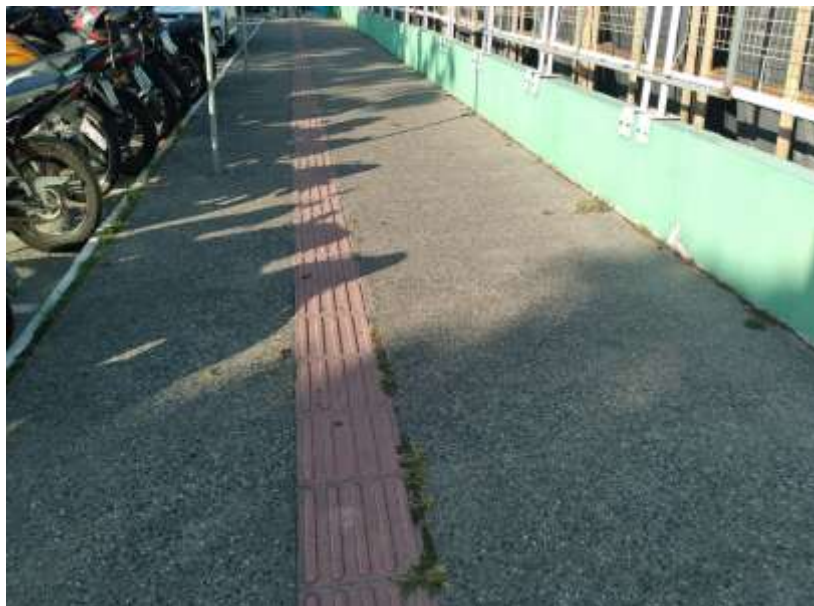
Figura 136 - Calçada com piso podotátil, existente na Avenida Atlântica, defronte a estação barra sul
