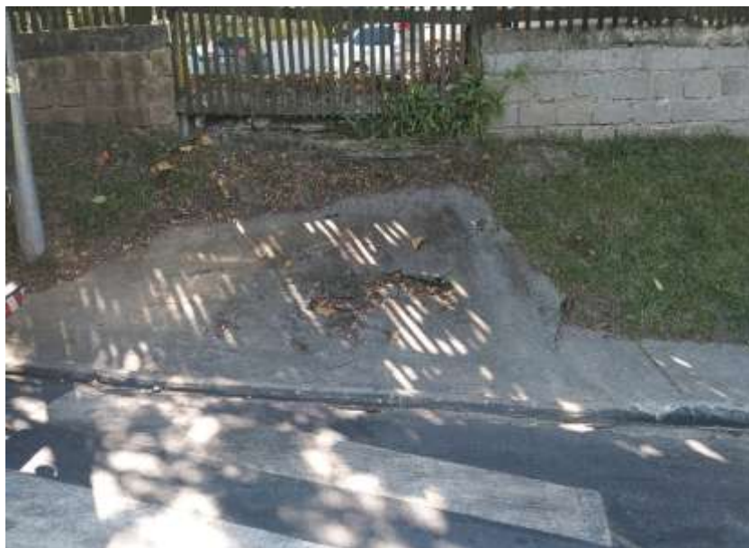
Figura 147 - Calçada em condições inadequadas e sem rampa de acessibilidade, existente na Avenida Rodesindo Pavan, do lado oposto ao acesso da estação laranjeiras.
