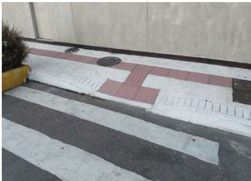
Figura 126 - Calçada com rampa de acessibilidade, existente na Avenida Normando Tedesco, do lado oposto ao acesso do estacionamento da estação barra sul.
