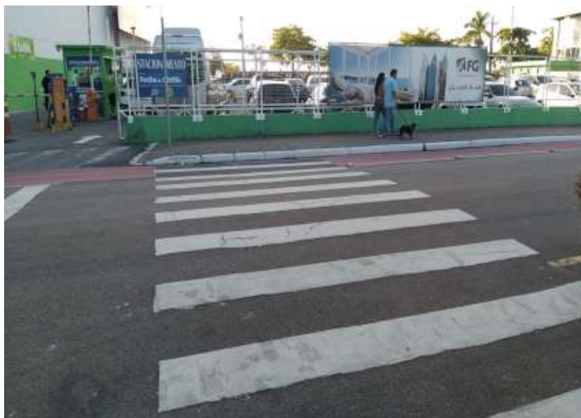
Figura 127 - Faixa de travessia de pedestres sem rampa de acessibilidade, existente na Avenida Normando Tedesco, ao lado do acesso do estacionamento da estação barra sul.
