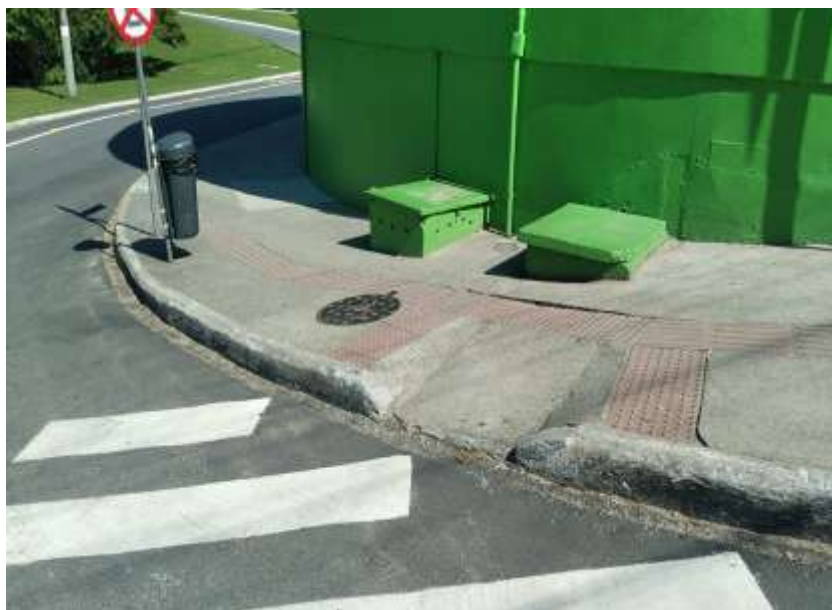
Figura 146 - Calçada com rampa de acessibilidade, existente na Avenida Rodesindo Pavan, na testada do acesso da estação laranjeiras.
