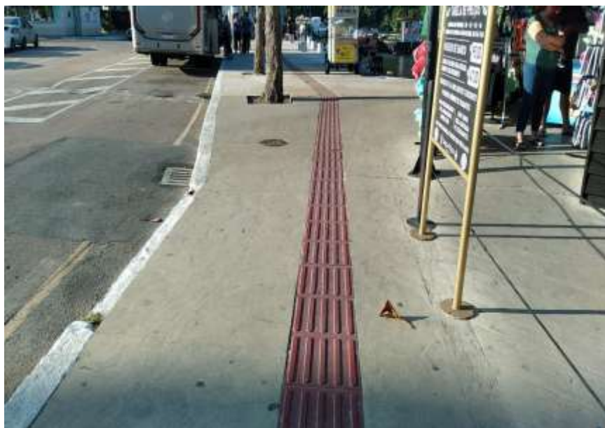
Figura 131 - Calçada com piso podotátil, existente no final da Avenida Normando Tedesco, do lado oposto ao acesso da estação barra sul.
